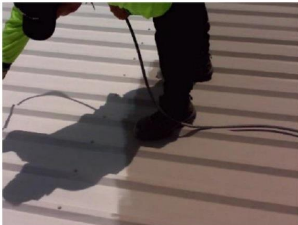
POMIARY IZOLACYJNOŚCI DACHU MAGAZYNU
